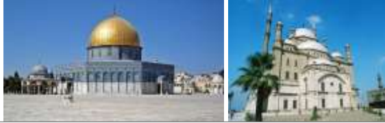
شكل (7) : الصورة الأولى : مسجد الصخرة - نرى القبة المركزية التي تشير إلى السماء ، الصورة الثانية : مسجد محمد علي - حيث القبة تحملها أربعة عقود كبيرة ترتكز أطرافها على أربعة أكتاف مربعة، ويحيط بالقبة أربعة أنصاف قباب ثم قبة خامسة ليغطي بروز المحراب عن جدار القبلة، بالإضافة إلى أربع قباب صغيرة بأركان المسجد.
